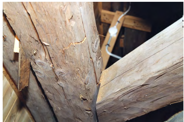
Figur 3.18 Berga kyrka a) Böjbrott i sparre. b) Klossar och virken har använts för att rätta upp sparrarna. Taktron är utbytt mot panel av modern typ.
