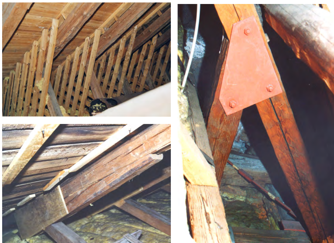
Figur 1.1 Åtgärder på kyrkvindar. a) Ryssby kyrka, Kronobergs län. b) Hjortsberga kyrka, Kronobergs län. c) Partille kyrka, Västra Götalands län.
