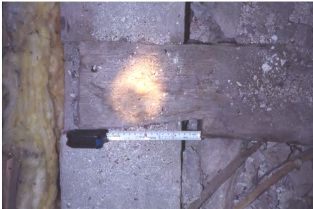
Figur 2.5 Isärdraget förband i takkonstruktionen över långhuset i Väske kyrka, Gotland
