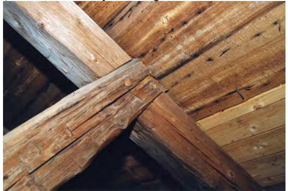
d) Saxsparrens infästning, Urshult.
