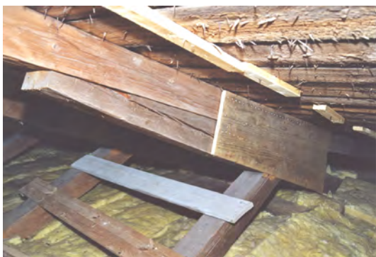
Figur 7.8 Hjortsberga. Förstärkt knutpunkt.
