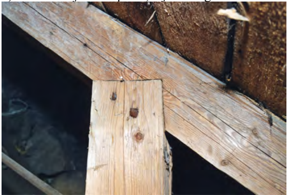
e) Det korta, yttre stödbenets infästning, Tingsås.
