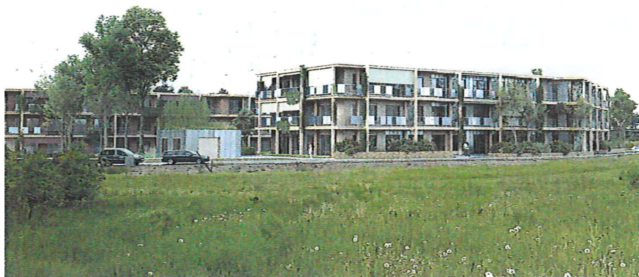
Figur 1: Fasad på förslag till bostäder. Designteam: Spridd, Nivå Landskapsarkitektur, Incoord och Kvarnstaden. (alla figurer)
