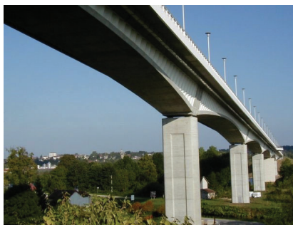
(a) Box-girder bridge, Pont en poutre-caisson, France [20]
