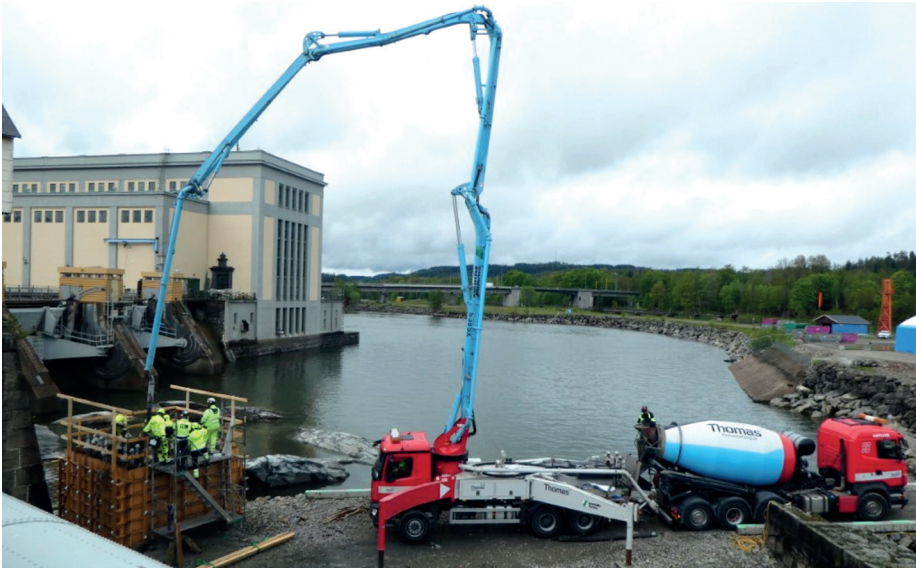
Gjutning av kranfundament i Lilla Edet.
