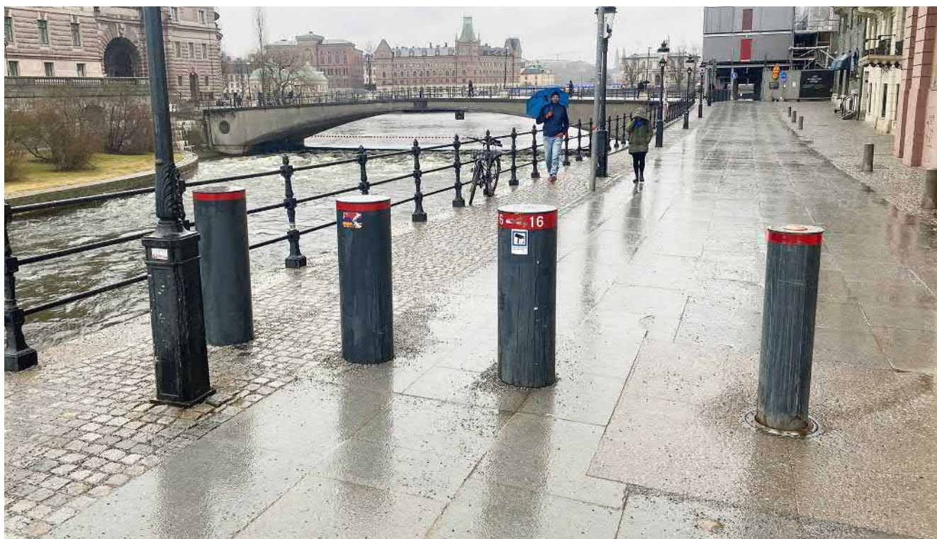
Automatiska pollare som endast släpper igenom behörig fordonstrafik.
