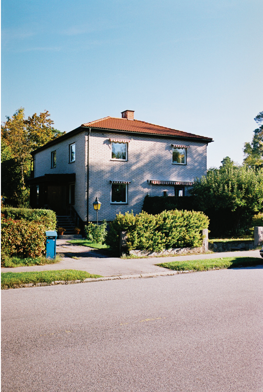
Figure 6. The Norra Ängby houses. Bebyggelseregistret.
