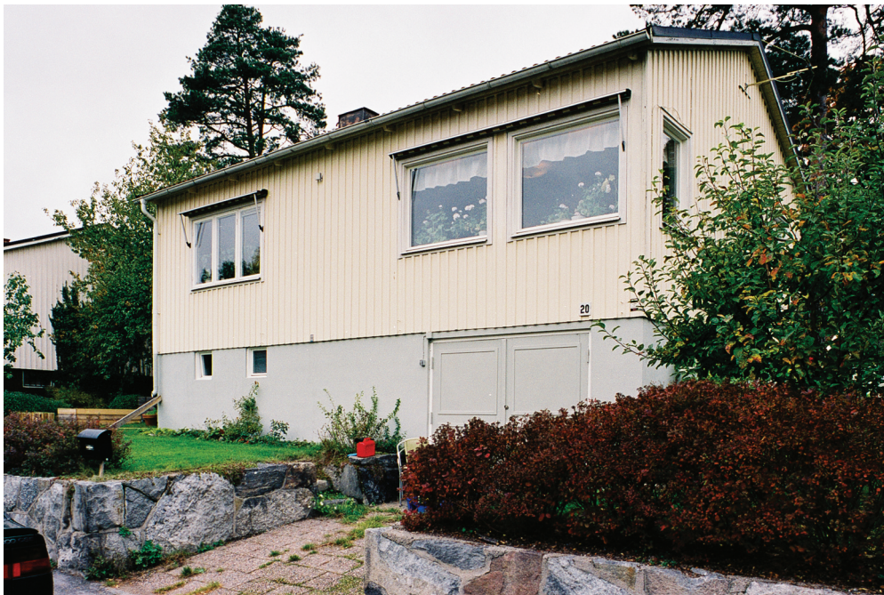
Figure 5. The Norra Ängby houses. Bebyggelseregistret.
