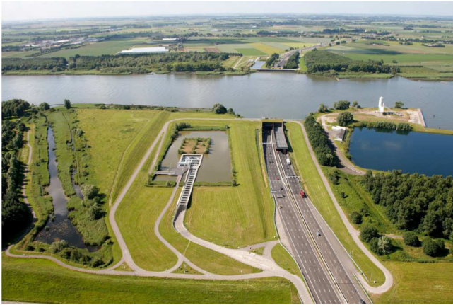
Fig. 11. The Eerste Heine Noord Tunnel (right) and the Tweede Heine Noord Tunnel (left). Image from https://beeldbank.rws.nl , Rijkswaterstaat.
