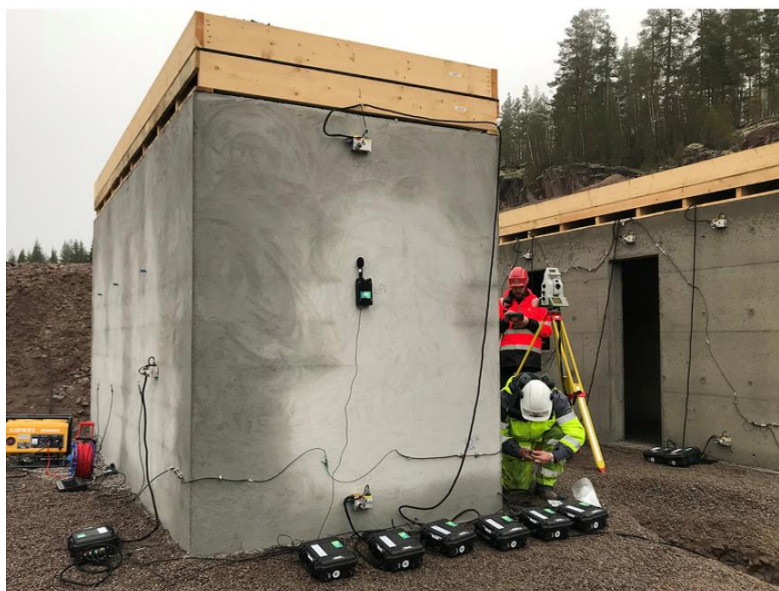
Figur A.2 Foto av instrumenterade betongbyggnader – främre byggnaden av Lecablock (dessa kan svagt skönjas bakom putsen) och den bakre av platsgjuten betong. Ovanpå byggnaderna syns de träkonstruktioner som fylldes med stenkross.
