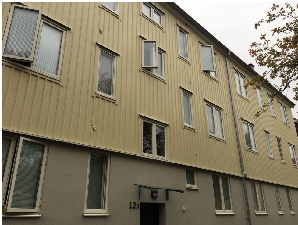
Figur 9: I en ny fas av om-renoveringar i området har fastighetsägaren använts utåtgående tvåluftsfönster som liknar originalfönstren. Foto: Författarna, 2018
