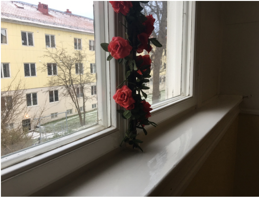
Figur 8: Originalfönster sett inifrån byggnad A2. Foto: Författarna 2018.
