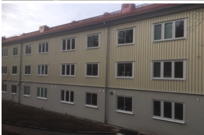
Figur 7 a-c: Byggnader i område A 2017. 7a, överst till vänster: Byggnad A2 med eternitplattor originalfönster i trä. Figur 7b, nederst till vänster: Byggnad A1, tilläggsisolerad och med den återskapade fasaden och nya fönster. Figur 7c höger: Byggnad A3 med bevarad originalfasad och nya fönster. Foton: Författarna.
