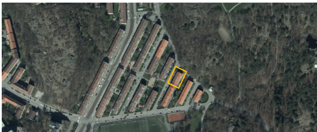
Figur 18: Flygfoto över området där fall C ligger före renoveringen 2014. Fastighet C markerad med ruta. Lantmäteriet: Ortofoto raster.
