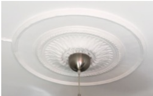
Figur 16 a-b: Nya stuckaturer i fastighet B. Figur 16a vänster: Takstuckaturer. Figur 16b höger. Lister mot taket i gips.
