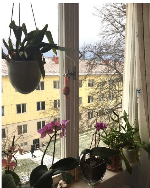
Figur 38 a-b: Gammalt sidoöppnat fönster respektive nytt fönster med falsk spröjs från insida bostad. Område A. Foto: Författarna
