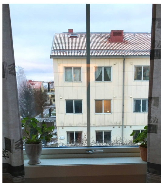
Figur 38 a-b: Gammalt sidoöppnat fönster respektive nytt fönster med falsk spröjs från insida bostad. Område A. Foto: Författarna
