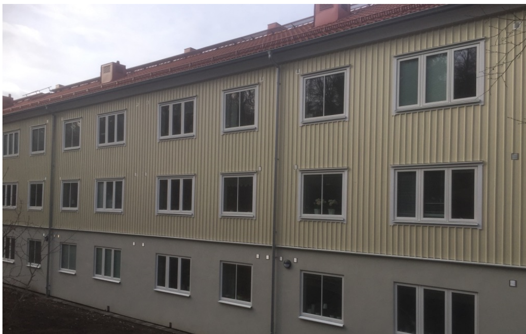
Figur 12. Den nya fasaden på fallstudie A efter den färdiga om-renoveringen 2017.
