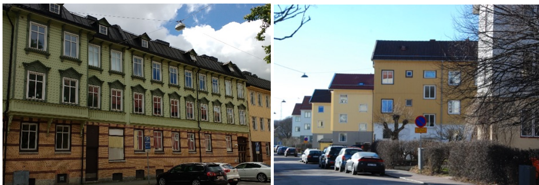
Figur 2 Exempel på äldre landshövdingehus (t.v) och yngre landshövdingehus (t.h.).
