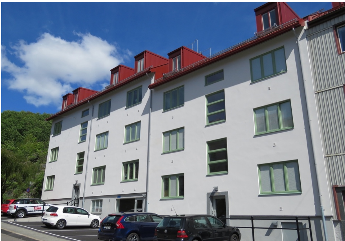
Figur 20. Fastighet C efter renoveringen, foto från 2017.
