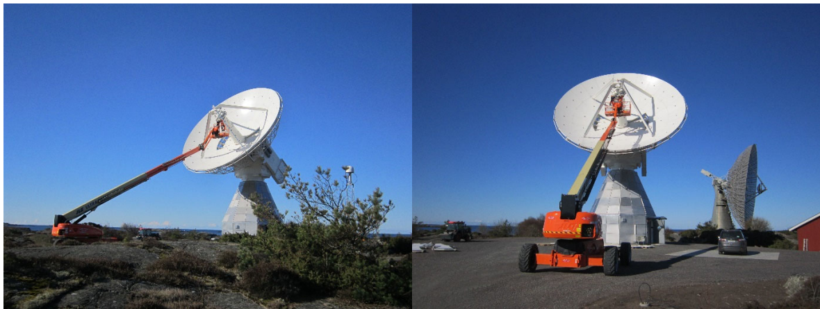
Abb. 2: Einsatz eines Krans zur Montage und Ausrichtung der Paneele
