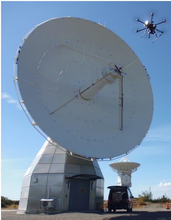
Abb. 1: Nordöstliches Onsala Twin Teleskop (ONSA13NE) mit Hexacopter während der Befliegung in der 0^\circ Elevationsposition.
