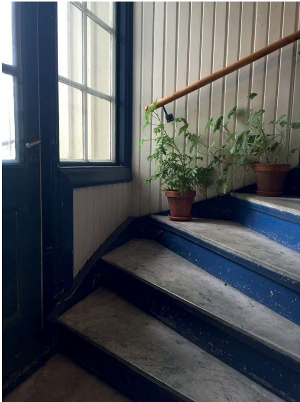
Figur 1: Banergatan i Göteborg, före renovering 2016
