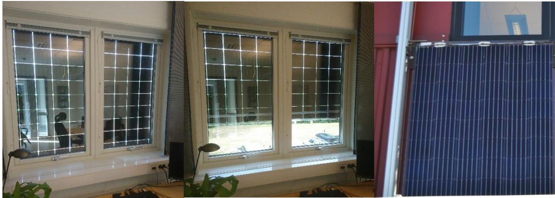
Figur 13 Den vertikala avskärmningen med transparenta glas-glasmoduler
