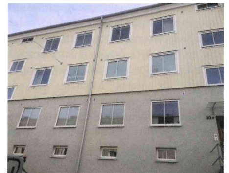
Figur 11: Tvåluftsfönstren blev i första etappen av om-renoveringen utbytta till pivothängda fönster som bryter mot originalarkitekturen.
