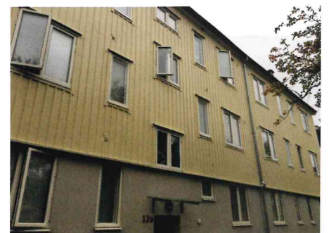
Figur 12: I en ny etapp av om-renovering har ett nytt tvåluftsfönster valts vilket stämmer bättre överens med originalarkitekturen.
