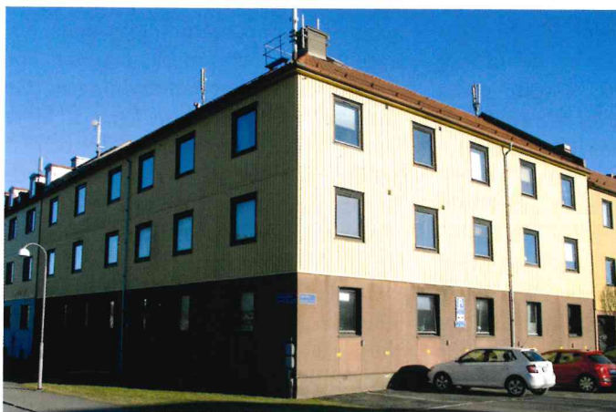
Figur 3: Område med yngre landshövdingehus i Lundby som blivit ändrade genom tilläggsisolering, nya fönster och nya fasadmateriell under 1970- eller 80-talet. I bakgrunden pågår en ombyggnad av vindar till lägenheter där takkupor som inte funnits tidigare tillkommer i större mängd.
