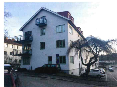
Figur 7: En fastighet uppförd 1935 som renoverades för första gången 2014. Renoveringen är väl utförd och gör den ursprungliga arkitekturen rättvisa.
