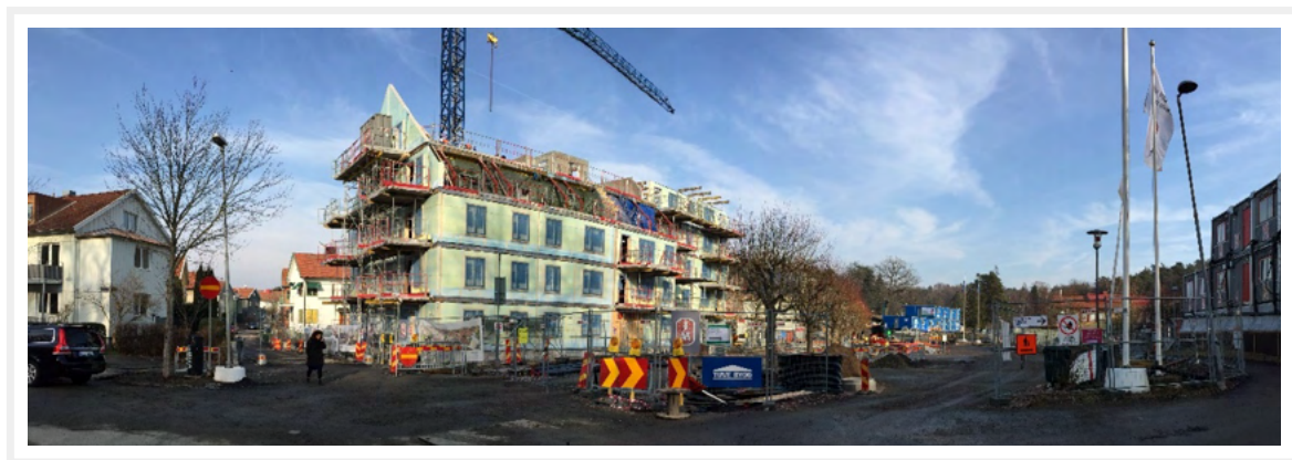
Östra Kålltorp, från Virginsgatan mot Renströmska parken (2019-02-16)
