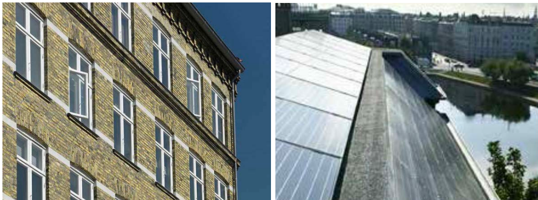
Figur 5. Samma byggnad som ovan. Takfoten är löst så att installationen inte inkräktar på fasadens anslutning till taket (Carøe Østergaard, 2015).
